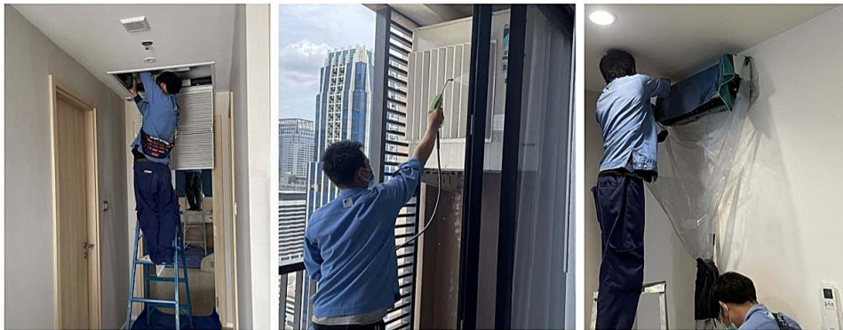
ภาพที่ 3-44 ล้างทำความสะอาดเครื่องปรับอากาศส่วนกลางประจำอาคาร
